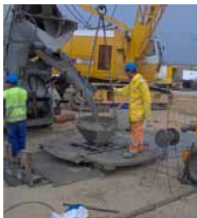
Fig. 49. Batache tapado con trámex y mesa de hormigonado con el hueco del tubo tremie para hormigonar. Fig. 50. Tramex para tapar todo un batache
