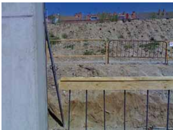
Fig. 63. Ejemplos de protección de esperas.
