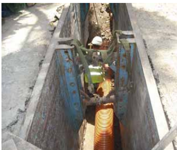
Fig. 28. Ejemplos de entibación.
