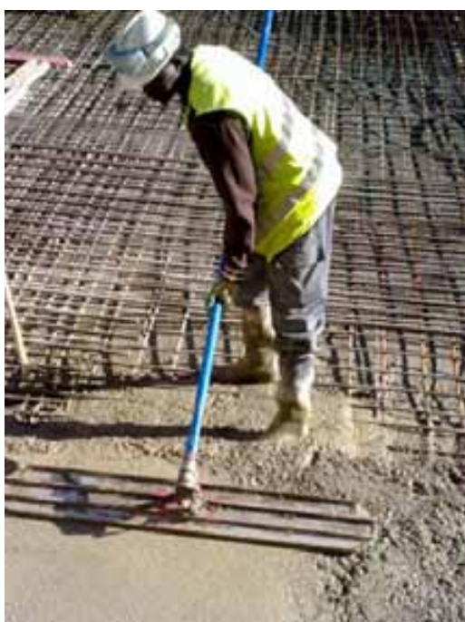
Fig. 67. Utilización de botas de seguridad altas para trabajos de hormigonado.
