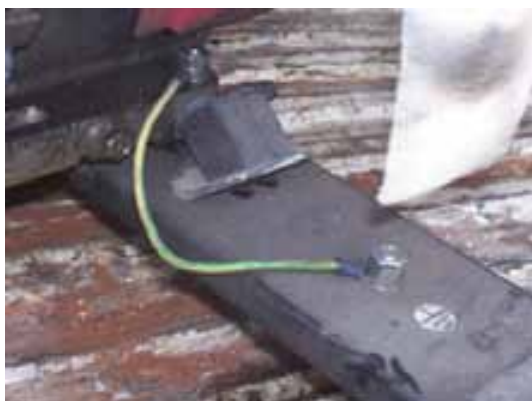
Fig. 85. Conexión de diferenciales y toma de tierra del grupo
