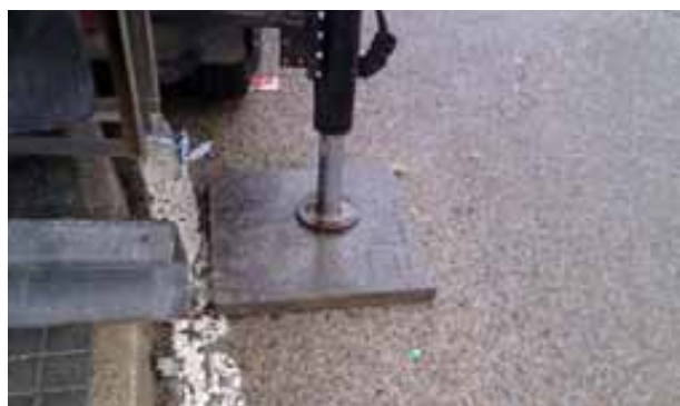
Fig. 117. Gatos de apoyo y reparto de cargas.
