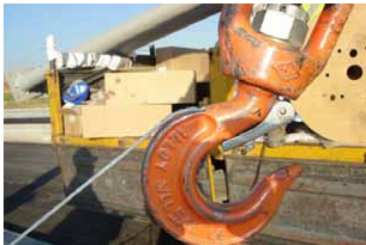
Fig. 118. Utilización de cuerda atada al pestillo de seguridad para deslingado del soporte.
