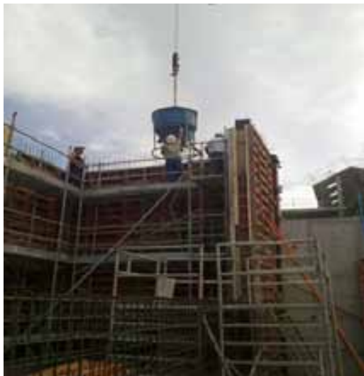
Fig. 66. Uso de equipos de auxiliares seguros para la ejecución del hormigonado de elementos en altura (cestas elevadoras, andamios).
