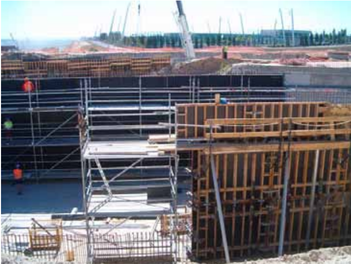
Fig. 68. Acceso al lugar de hormigonado mediante andamio o escalera.
