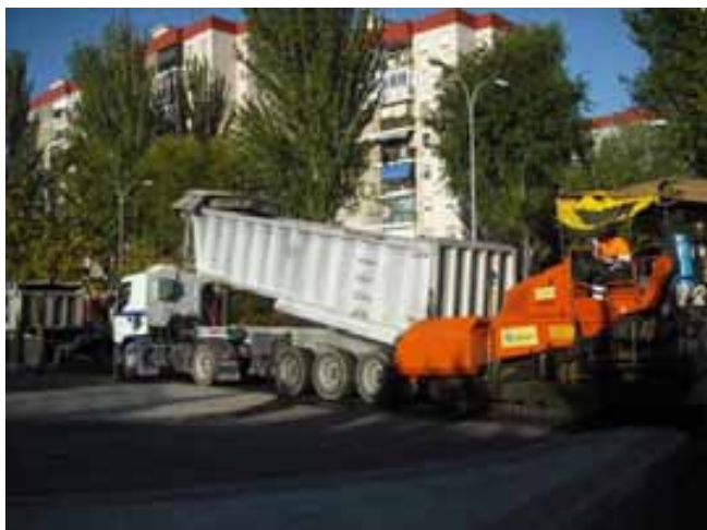
Fig. 96. Vertido sobre tolva sin presencia de personal ajeno en las proximidades
