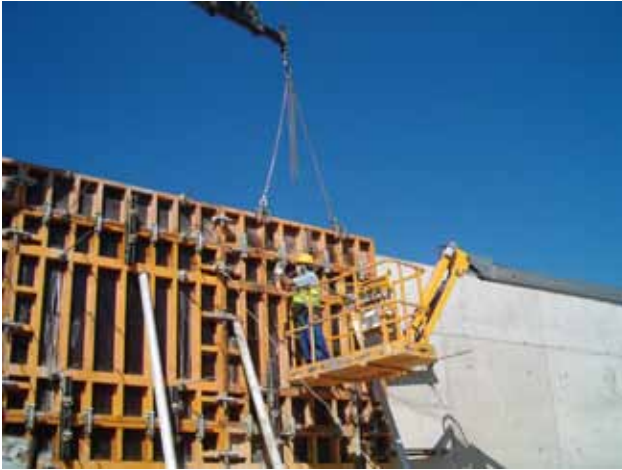
Fig. 65. Trabajos de montaje de paneles de encofrado mediante plataforma elevadora o escalera y arnés de seguridad.
