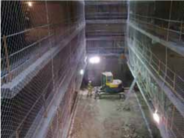
Fig. 74. Ejemplos de protecciones colectivas en trabajos de forjado.
