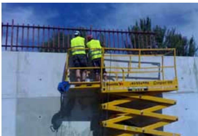
Fig. 103. Trabajos de pintura. Plataformas elevadoras para trabajos en altura.
