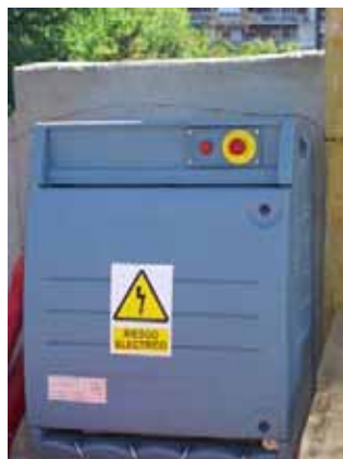
Fig 7. Cuadros eléctricos situados en altura, cerrados y con protección. Toma de tierra y señalización de riesgo eléctrico.
