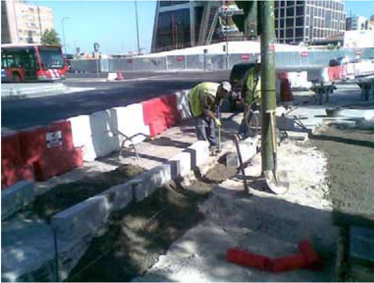
Fig. 89. Ejemplos de útiles para la colocación de bordillos
