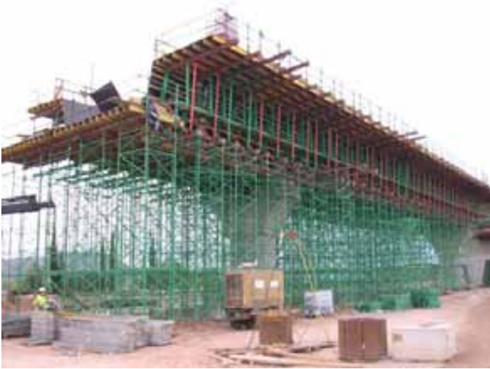
Fig.13. Cimbrado y protecciones de losa en paso inferior y en viaducto.
