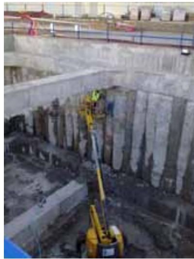
Fig. 83. Distintos trabajos en altura realizados mediante plataformas elevadoras.
