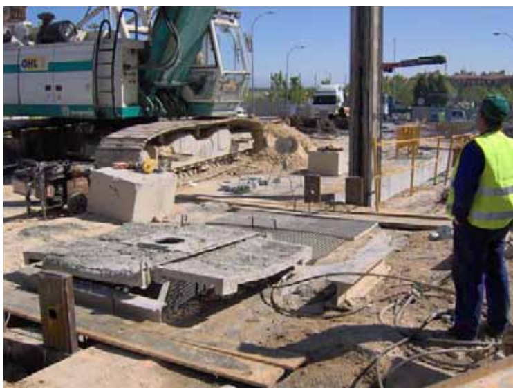
Fig. 47. Pantalladora de bastidor rígido y vallado en el lado opuesto de la pantalladora. Dados de hormigón como puntos fijo para anclaje de arnés de seguridad con bloque retráctil.
