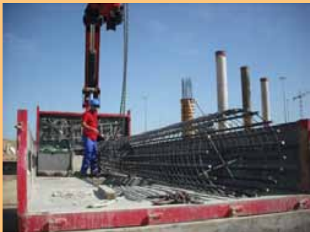
Fig. 19. Utilización de durmientes en caja del vehículo para facilitar el enganche.
