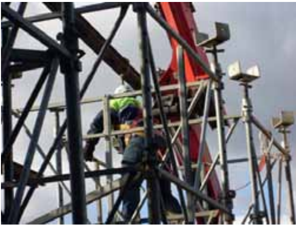
Fig.14. Montaje utilizando arnés con doble cuerda
