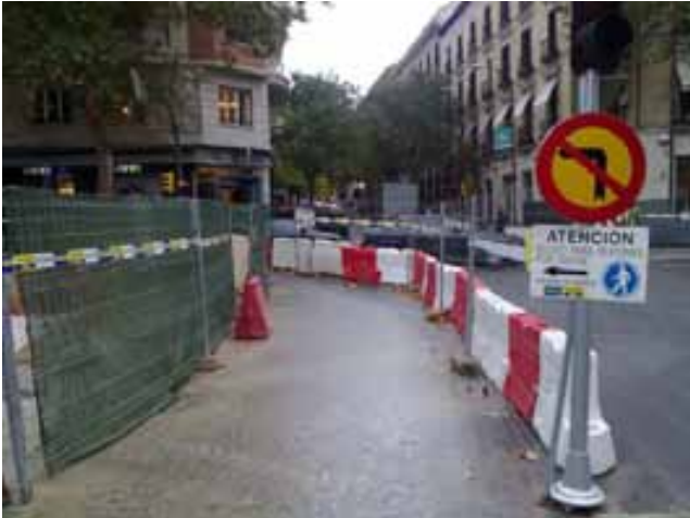
Fig. 37. Señalización, pasarelas y pasillos por el paso de peatones.
