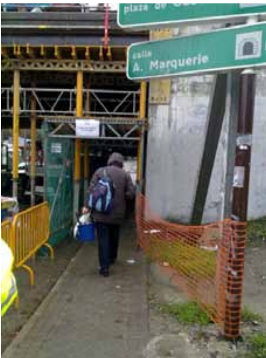
Fig. 38. Pasos protegidos contra el riesgo de caída de objetos en altura.
